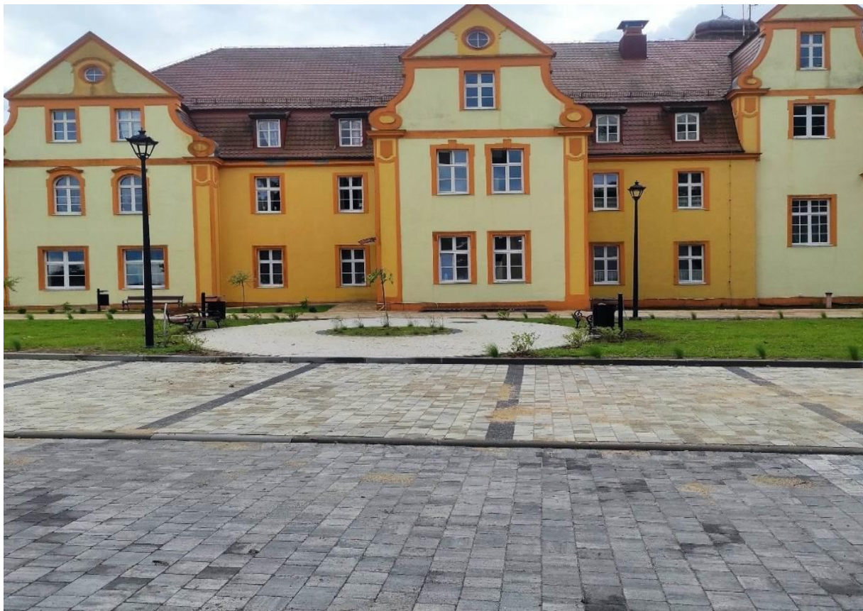
Zdjęcie 15. Budynek Domu Pomocy Społecznej w Brzezinach w trakcie realizacji inwestycji pn. „Zagospodarowanie przestrzeni terenu przy Domu Pomocy Społecznej w Brzezinach”
