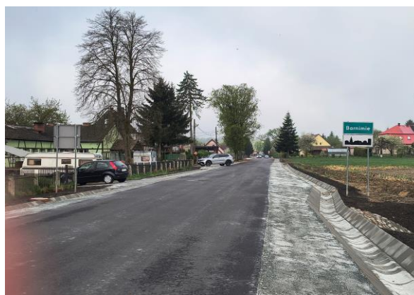
Zdjęcie 17. Droga nr 2224Z w m. Barnimie po przebudowie
