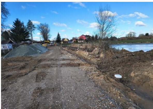
Zdjęcie 18. Droga powiatowa nr 2224Z w m. Barnimie w trakcie przebudowy
