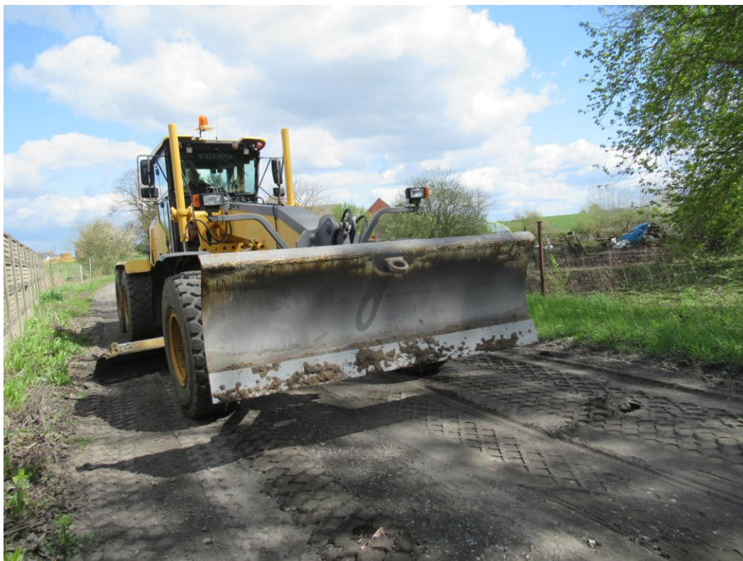
Zdjęcie 22. Profilowanie drogi
