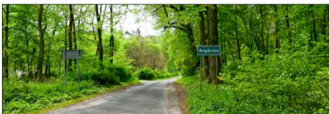
» Droga Bogdanka-Sitnica przed remontem
