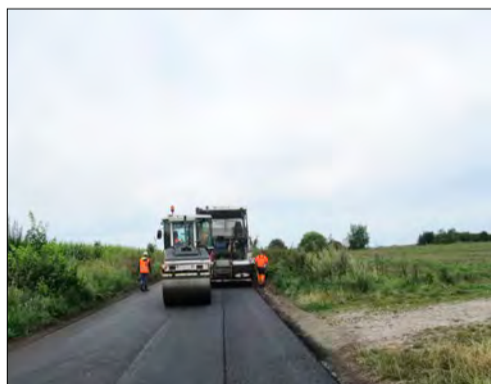
» Droga powiatowa nr 2206Z na odcinku Choszczno - Gleżno w trakcie remontu
