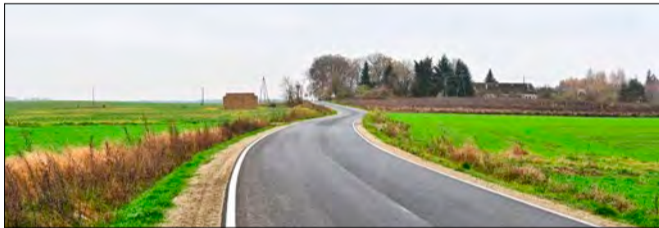
» Droga Recz - Żeliszewo po modernizacji
