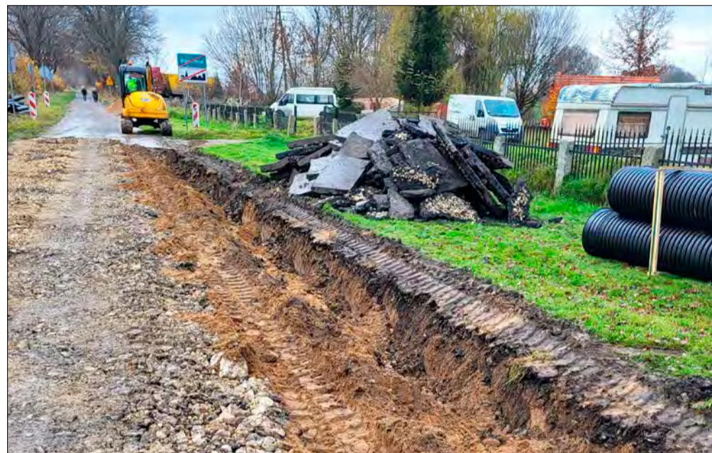
» Przebudowa drogi nr 2224Z w miejscowości Barnimie w trakcie robót.
