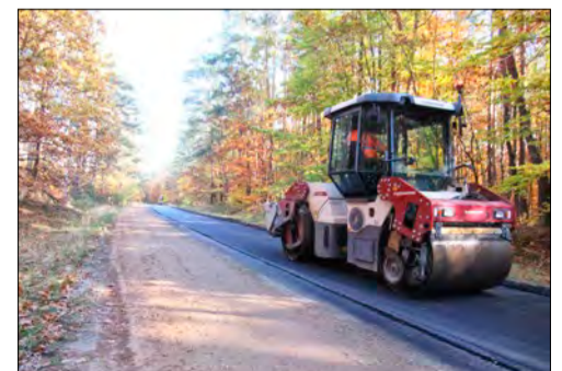
» Droga Konotop-Zatom w trakcie przebudowy
