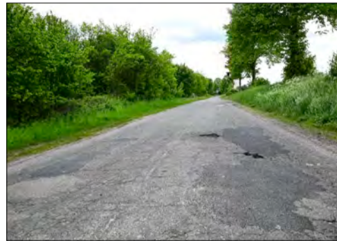
» Droga Słonice-Rakowo - przed modernizacją
