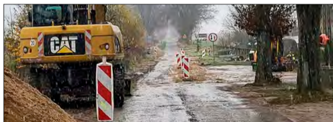
» Przebudowa drogi nr 2224Z w miejscowości Barnimie w trakcie robót.
