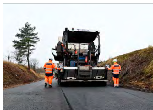
» W trakcie modernizacji
