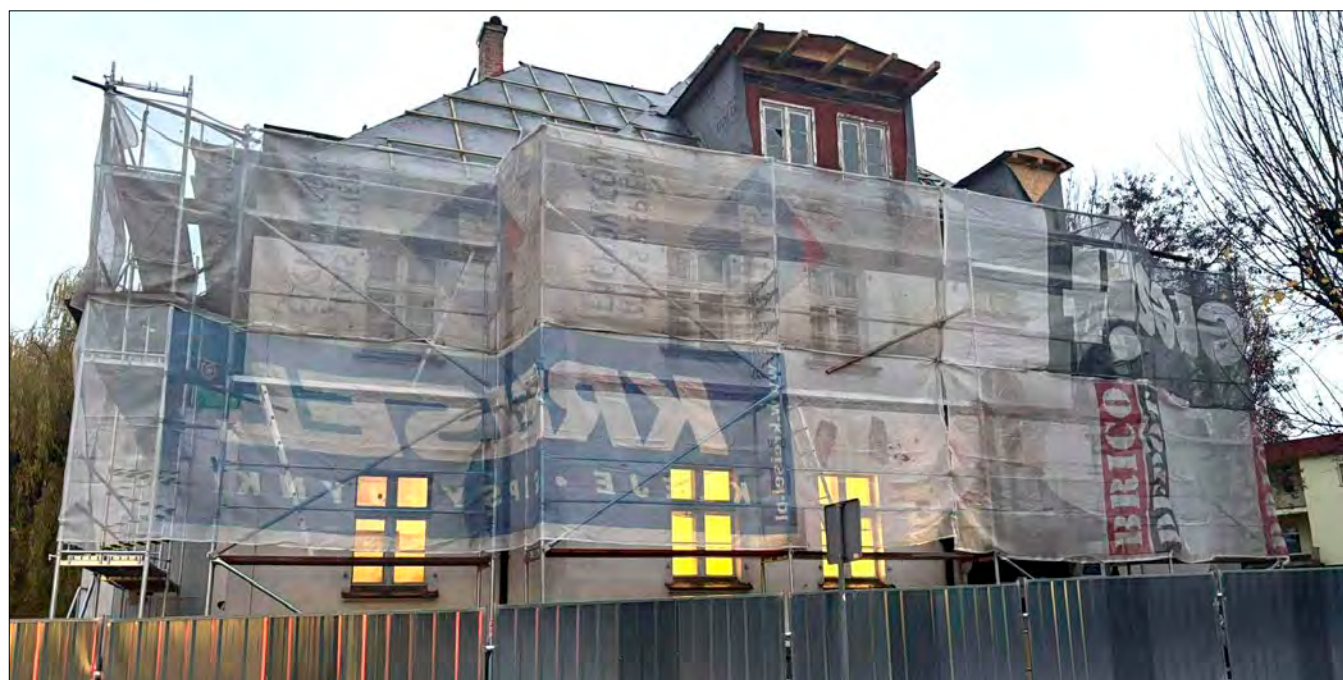
» Remont budynku po byłym pogotowiu
