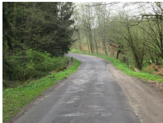
Zdjęcie 25. Odcinek drogi w miejscowości Zatom
