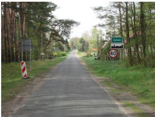
Zdjęcie 24. Odcinek drogi w miejscowości Zatom
