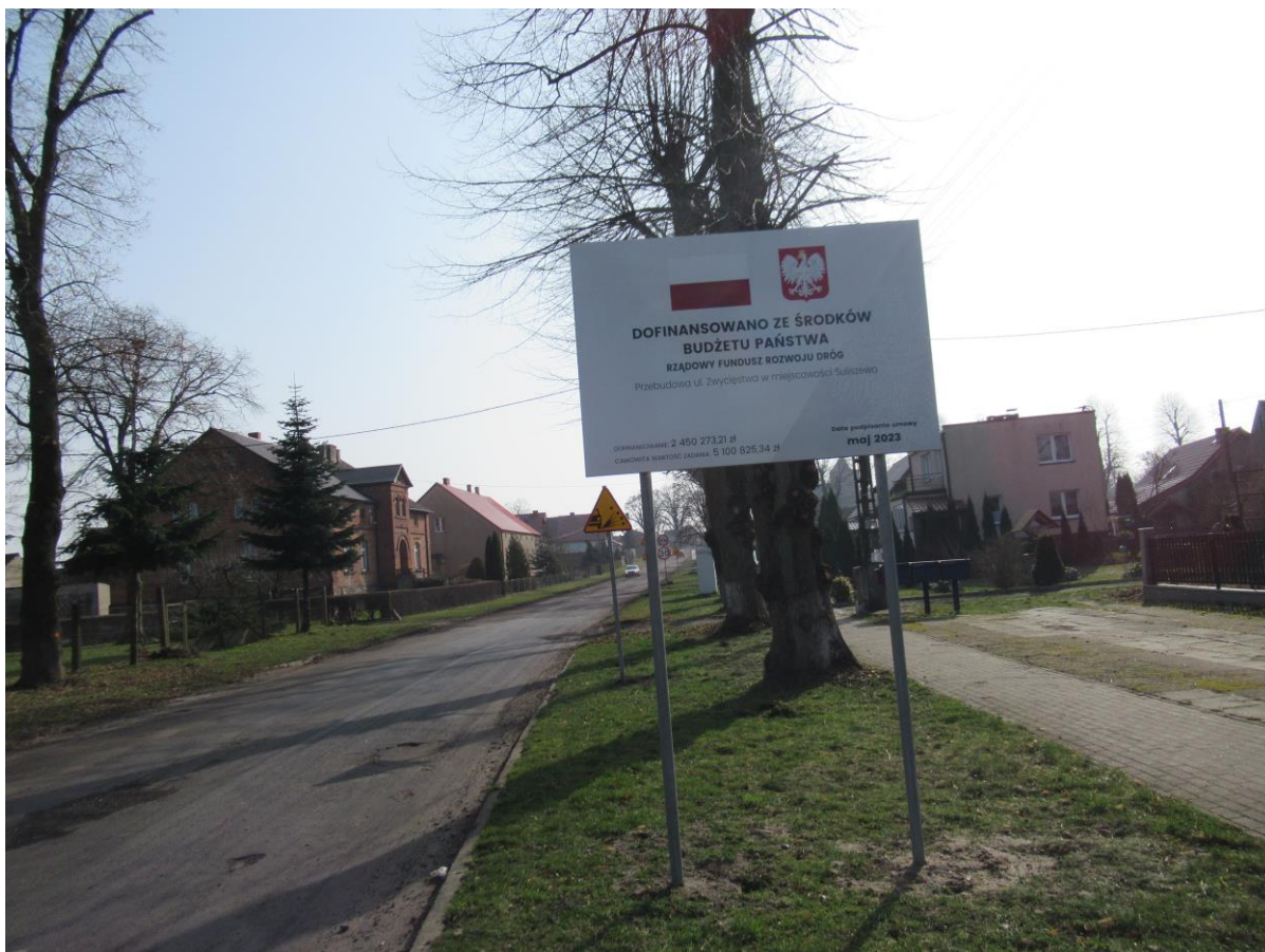
Zdjęcie 20. Przebudowa ul. Zwycięstwa w miejscowości Suliszewo
