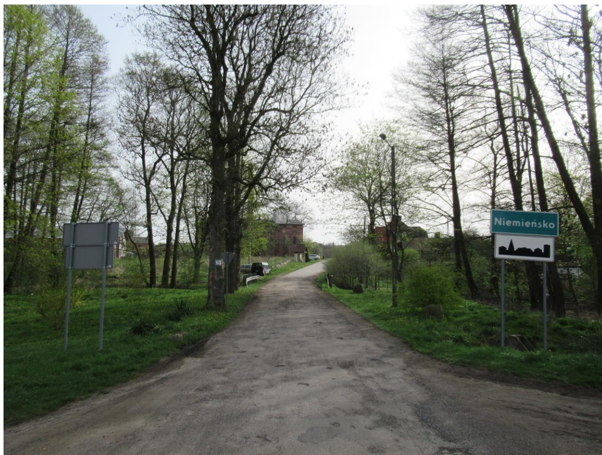
Zdjęcie 26. Droga powiatowa nr 2237Z w miejscowości Niemieńsko
