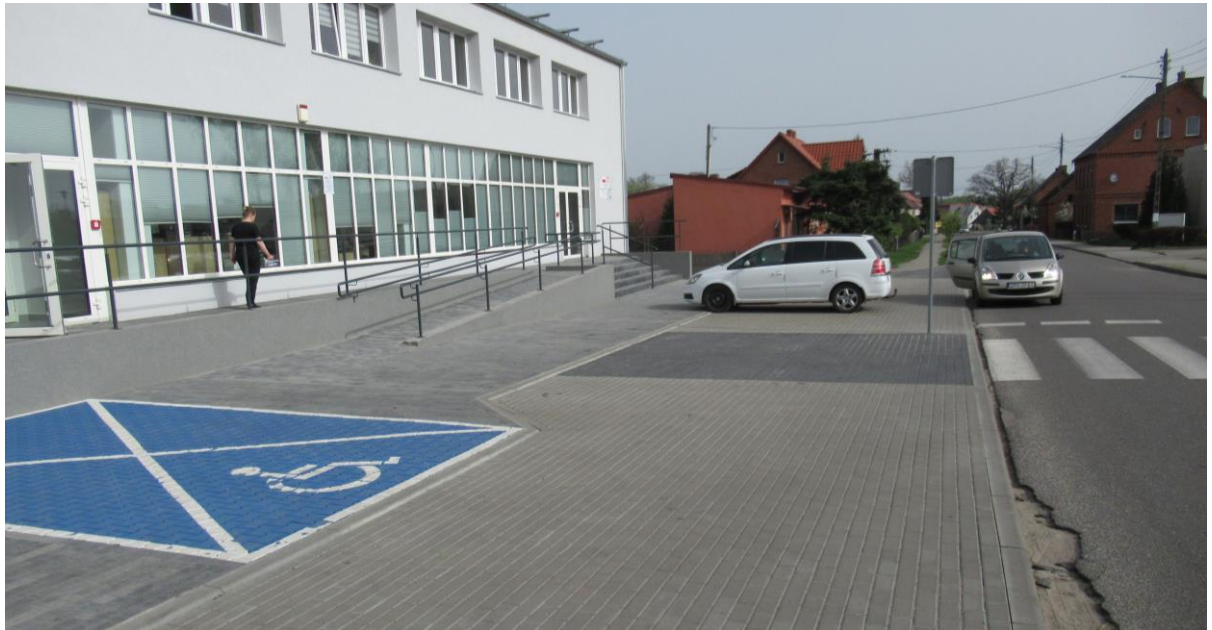
Zdjęcie 28. Chodnik w miejscowości Bierzwnik ul. Sienkiewicza
