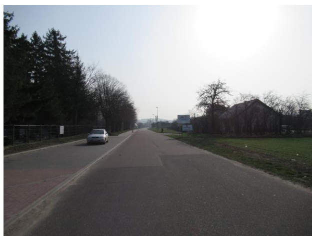
Zdjęcie 22. Droga powiatowa nr 2222Z w miejscowości Chłopowo
