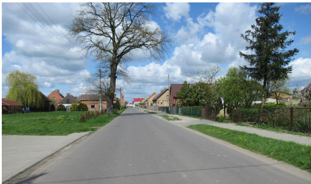
Zdjęcie 8. Droga powiatowa nr 2206Z na odcinku Zamęcín - Stary Klukom
