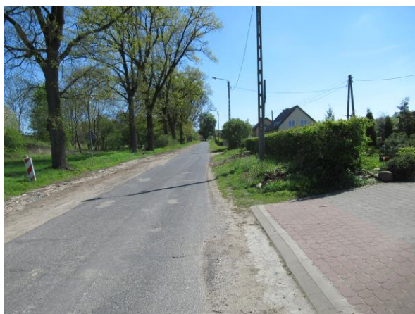
Zdjęcie 11. Pobocze w miejscowości Pomień przed budową chodnika
