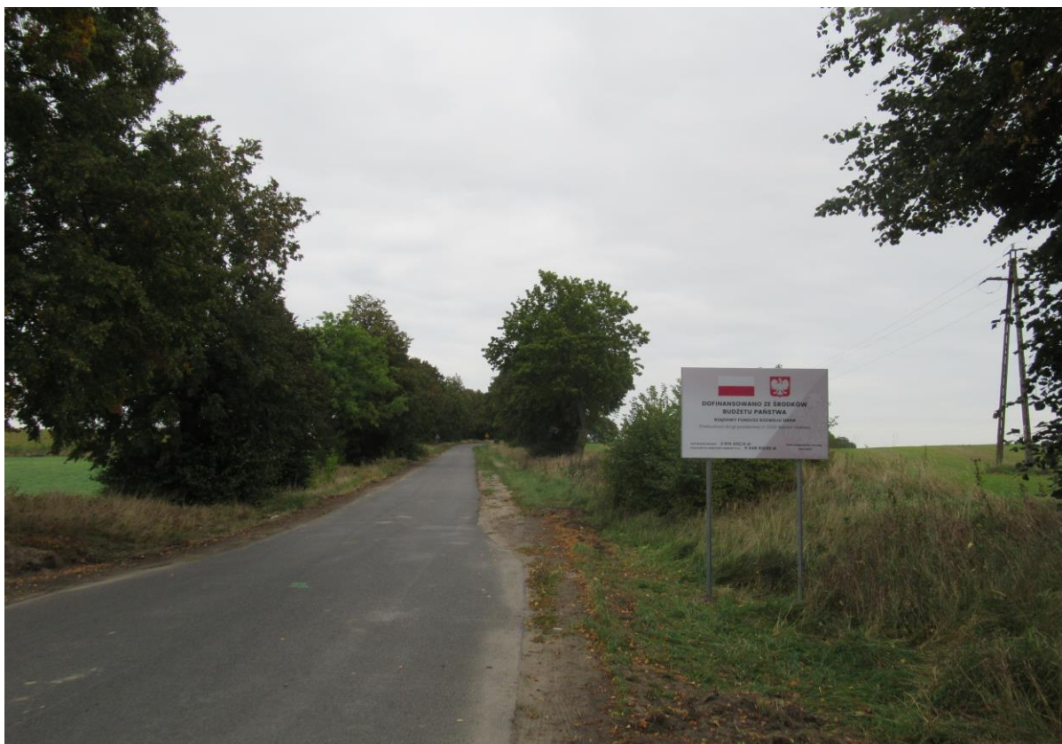
Zdjęcie 21. Odcinek remontowanej drogi powiatowej nr 2212Z Słonice-Rakowo
