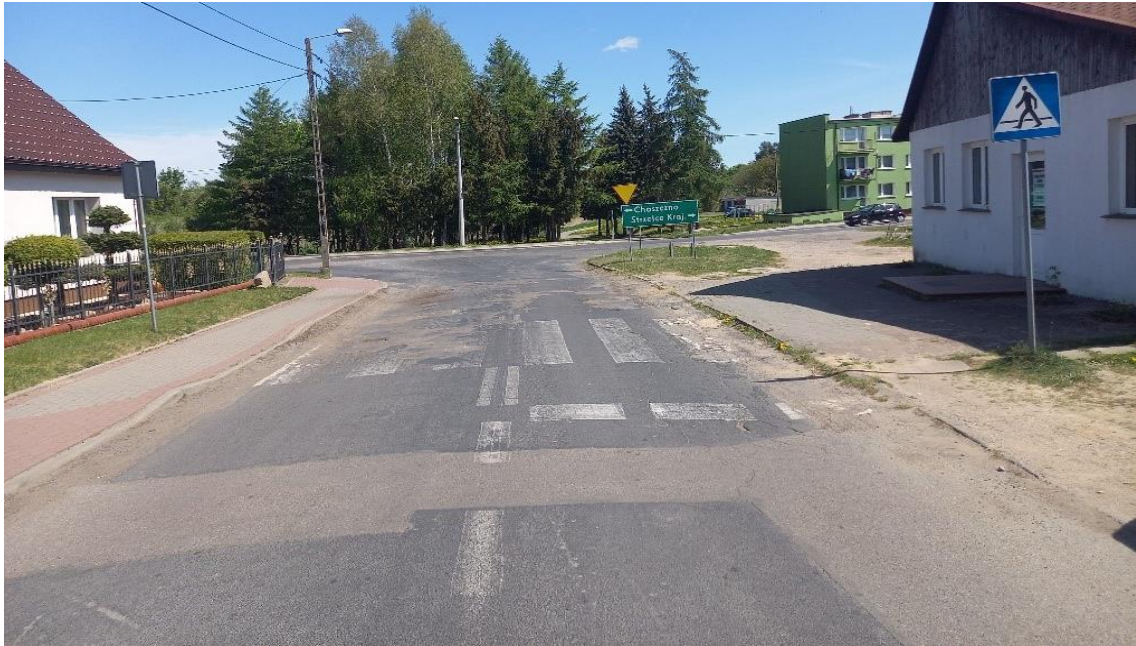
Zdjęcie 9. Droga powiatowa przed remontem
