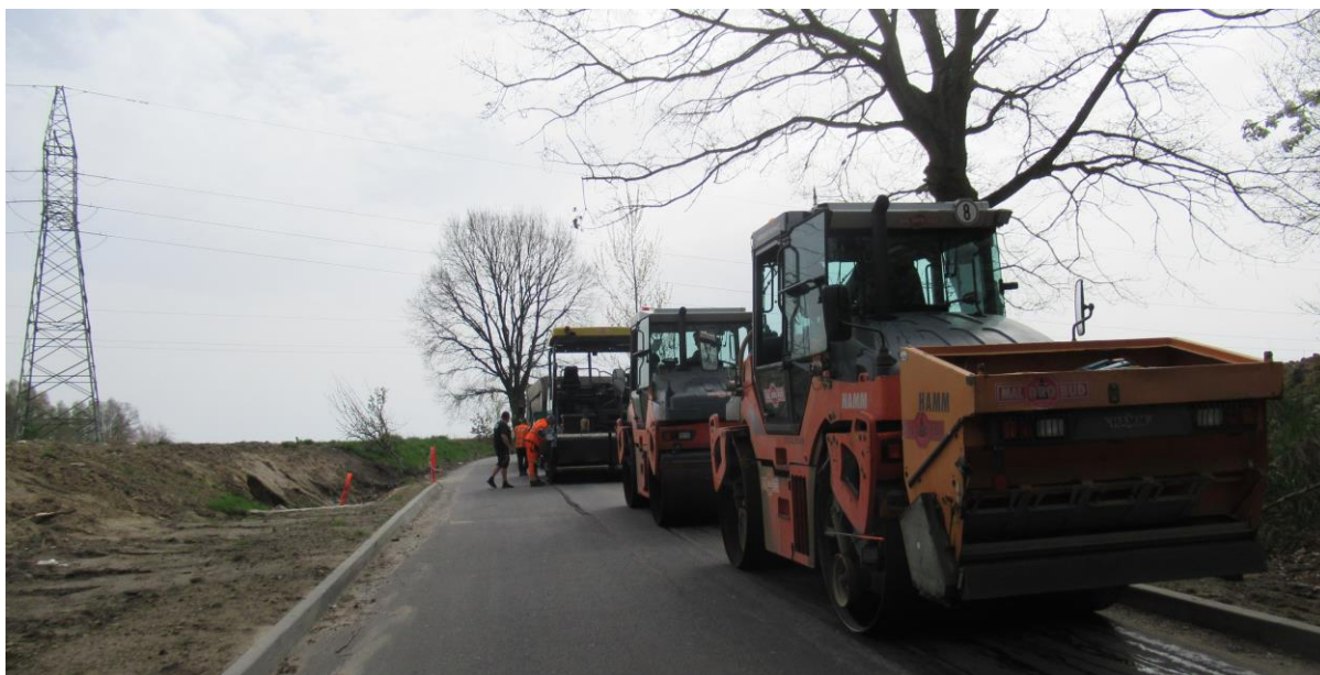
Zdjęcie 19. Prace remontowe na drodze w Żeliszewie
