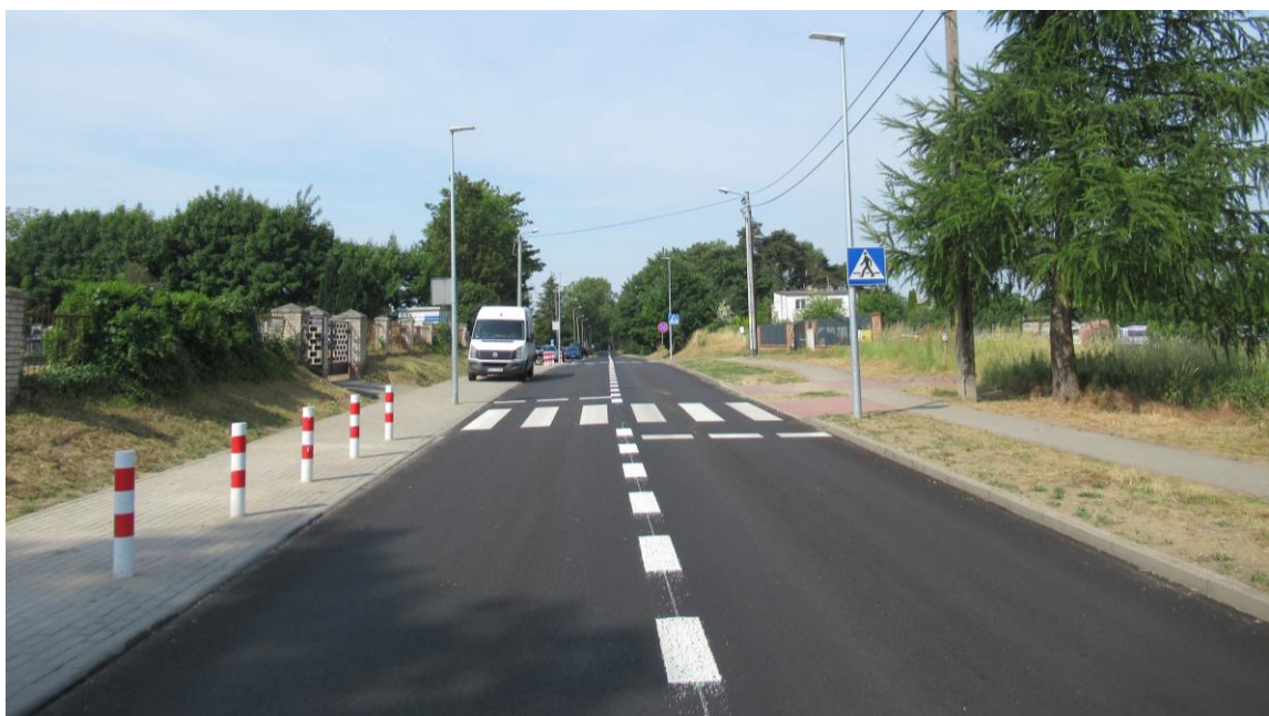
Zdjęcie 10. Droga powiatowa po remoncie
